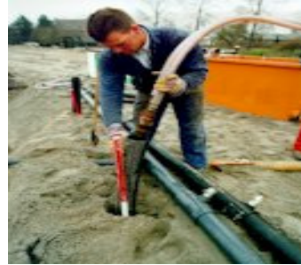
b. plaatsen Venturi pompen
