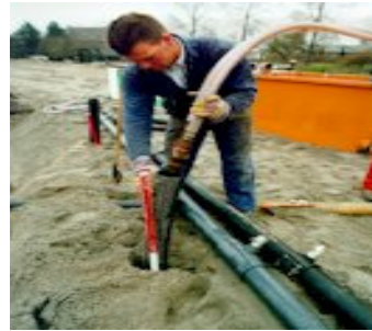
b. plaatsen Venturi pompen
